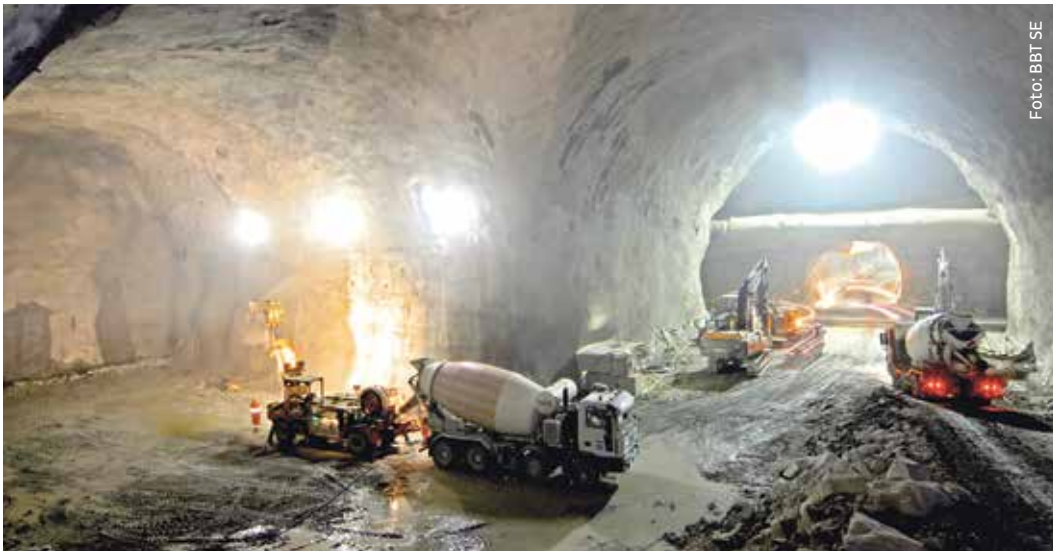
Die Abwässer vom BBT werden zum Heizen und Kühlen von Gebäuden verwendet.
