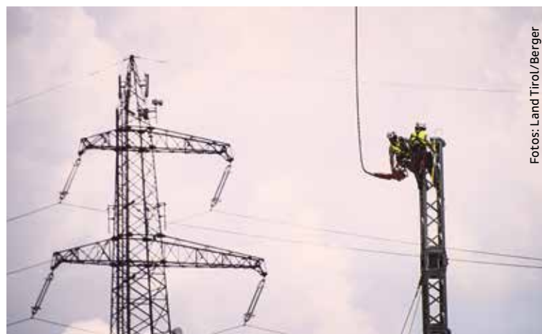
Die TINETZ stellt nach einem angenommenen Anschlag auf die 220 kV-Leitung in Absam ihr Ersatzgestänge auf.
