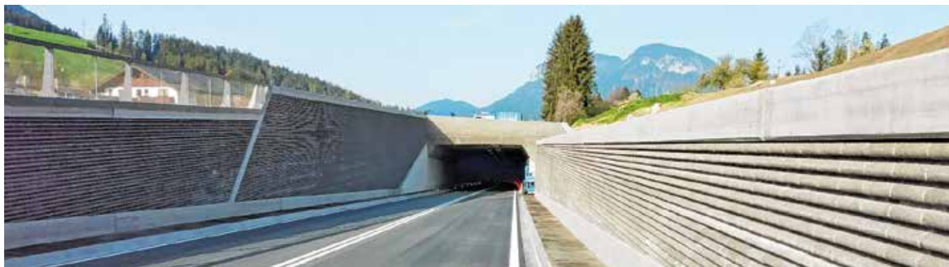
In Scheffau am Wilden Kaiser (Bezirk Kufstein) konnte die Lärmbelastung entlang der B 178 Loferer Straße für die Bevölkerung dank der 430 Meter langen Unterflurtrasse spürbar reduziert werden. Die Lärmbelastung ging um rund ein Drittel zurück.
