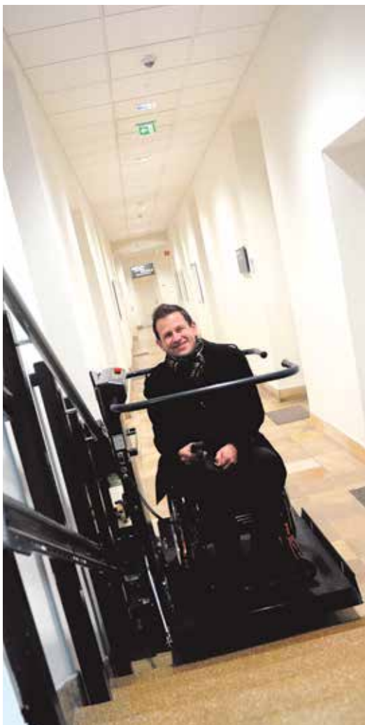
Zug um Zug werden die Landesgebäude barrierefrei gemacht. Hier ein Treppenlift im Alten Landhaus in Innsbruck.
